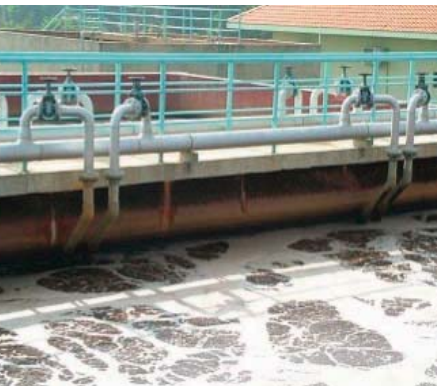
Hình ảnh trạm xử lý nước thải KCN Lê Minh Xuân
