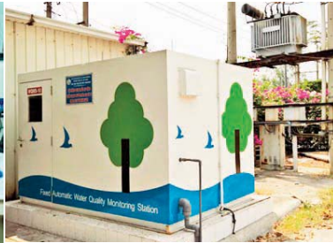
Hệ thống quan trắc tự động đo chất lượng nước thải sau xử lý
